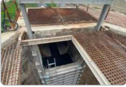
Arıtma Ekipman Montaj ve Demontajı
