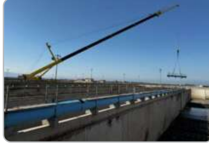
Borulama Montaj ve Demontajı
